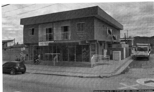
Figura 1 – Fachada do Imóvel em maio de 2012
